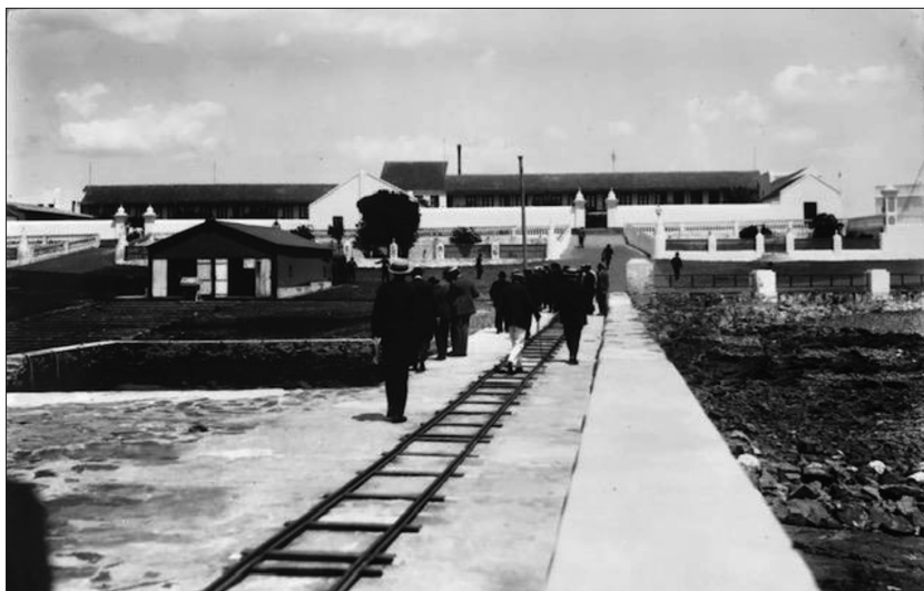
Muelle de entrada de los pasajeros y funcionarios a las instalaciones de la isla
